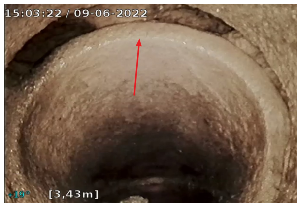
Foto 04: Odchylka polohy, v horní části
