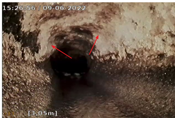
Foto 06: Inkrustace na stěnách, tuk – v horní části
