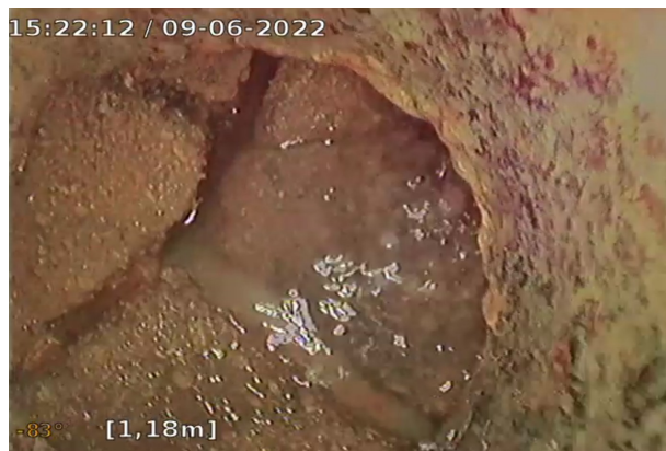
Foto 05: Trhlina, dno – komplexní tvorba
